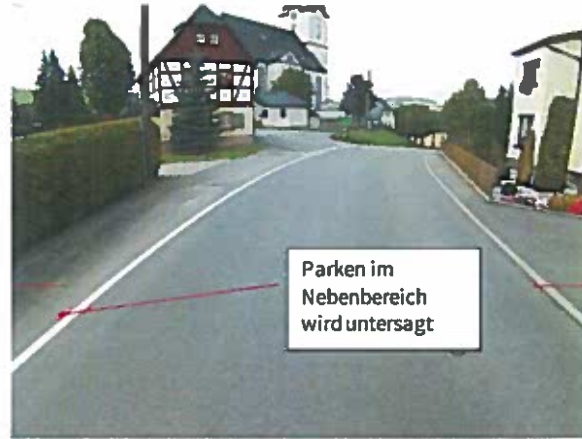
Richtung Ortsmitte Drebach, die Freifläche zur Hecke könnte zum Gehwegbau genutzt werden. Ein dort inzwischen bestehendes Zeichen 286 (eingeschränktes Halteverbot) wird um das Zusatzzeichen 1060-31 („auch auf dem Seitenstreifen“) ergänzt, damit deutlich wird, dass dort auch neben der Straße nicht geparkt werden darf.
